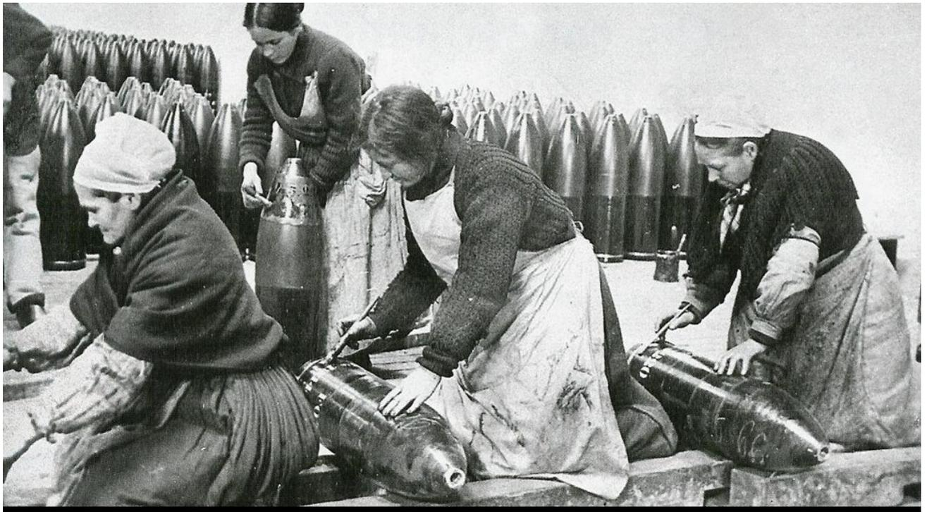
Mise en peinture et apposition des indications de chargement au stencil sur ces obus de gros calibre
