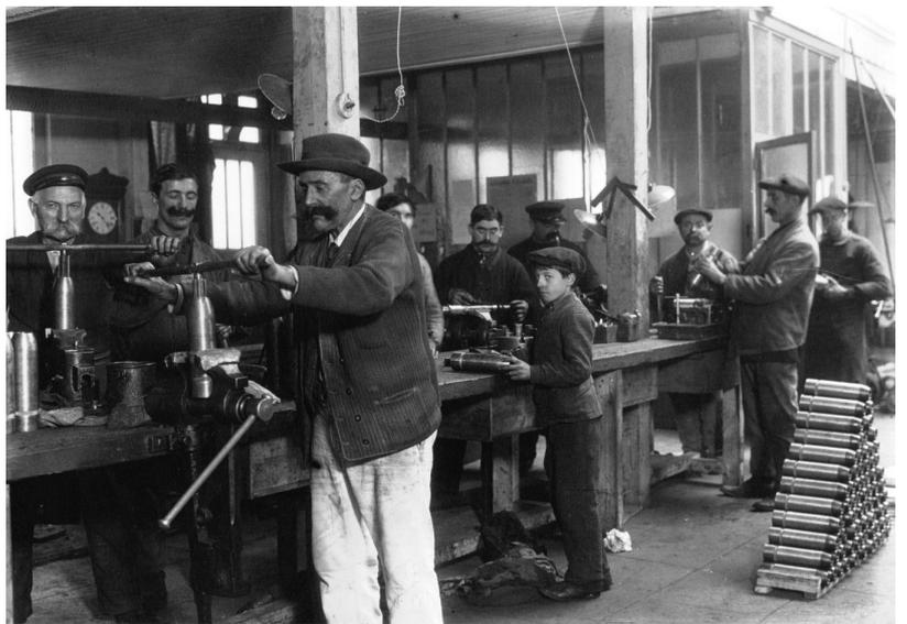
L'œil est fileté sur machine ou à la main afin de pouvoir ultérieurement y visser la gaine ou la fusée
