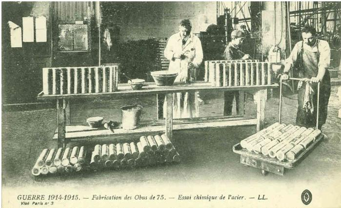
Avant de poursuivre l'usinage, un contrôle de la qualité de l'acier est réalisé en laboratoire;
